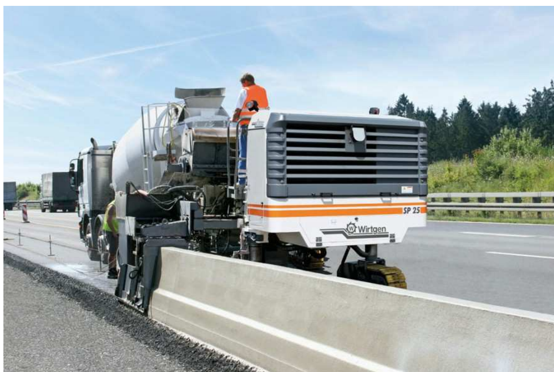
Figur 3 Glidformsgjutning av vägbarriär (Källa: www.wirtgen.se )
