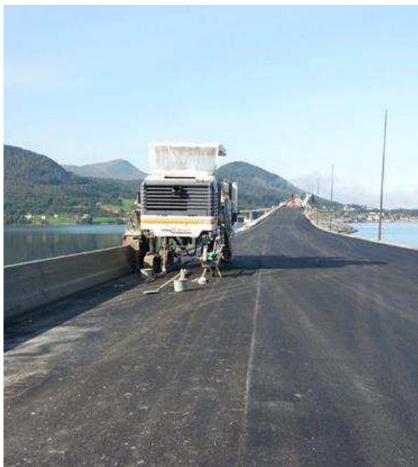
Figur 2 Gjutning av betongräcke i Norge 2015, NCC Profilbetong
